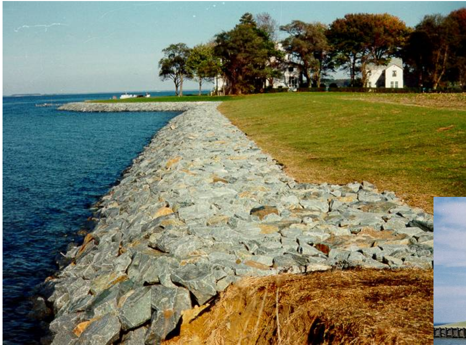
Rip-rap or Revetment
